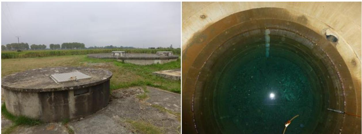
Figure 3 : puits de Layrac – à gauche : vue d'ensemble ; à droite : vue de l'intérieur du cuvelage béton (le fond de l'ouvrage est visible par transparence).
