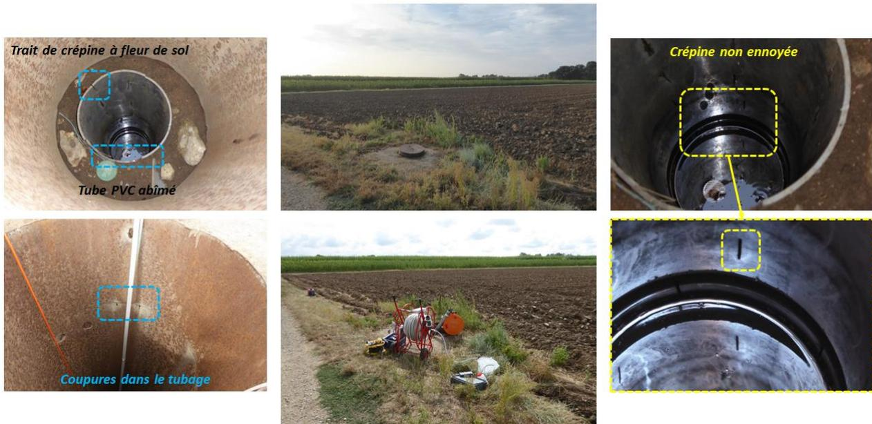
Figure 44 : principales caractéristiques techniques du puits de la Fosse Thibaudeau (Suèvres) et aperçu des investigations réalisées sur site.
