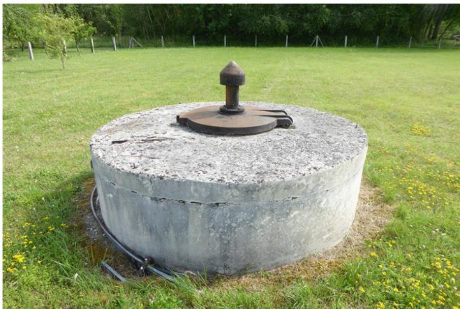
Figure 70 : aperçu des tubes présents à l'extérieur du puits.
