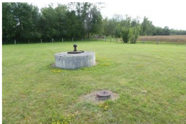
Figure 1 : ouvrage de reconnaissance PF (premier plan) et puits GF de la station de Gaye
