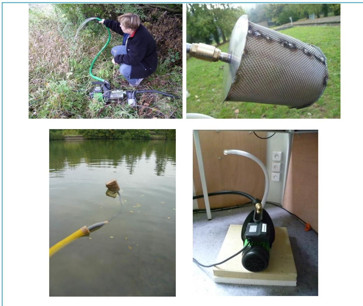
**Figure 7 : Essais de pompage et mise en place de la crépine dans la rivière**
