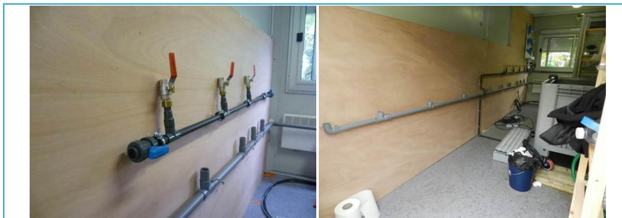
Figure 6 : Photo du montage des circuits d'alimentation en eau de rivière (noir) et d'évacuation (gris)
