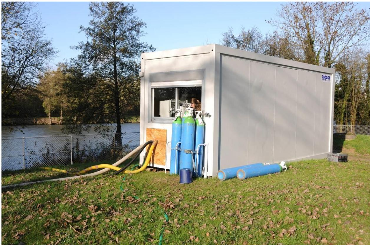
Figure 5 : Photo de l'arrière de la station avec la trappe permettant le passage des tuyaux d'alimentation et d'évacuation d'eau de rivière, ainsi que de l'air comprimé.
